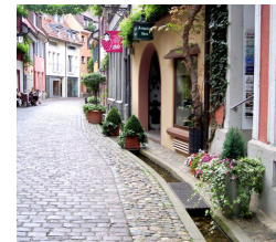
Afvoer regenwater met watergoten
