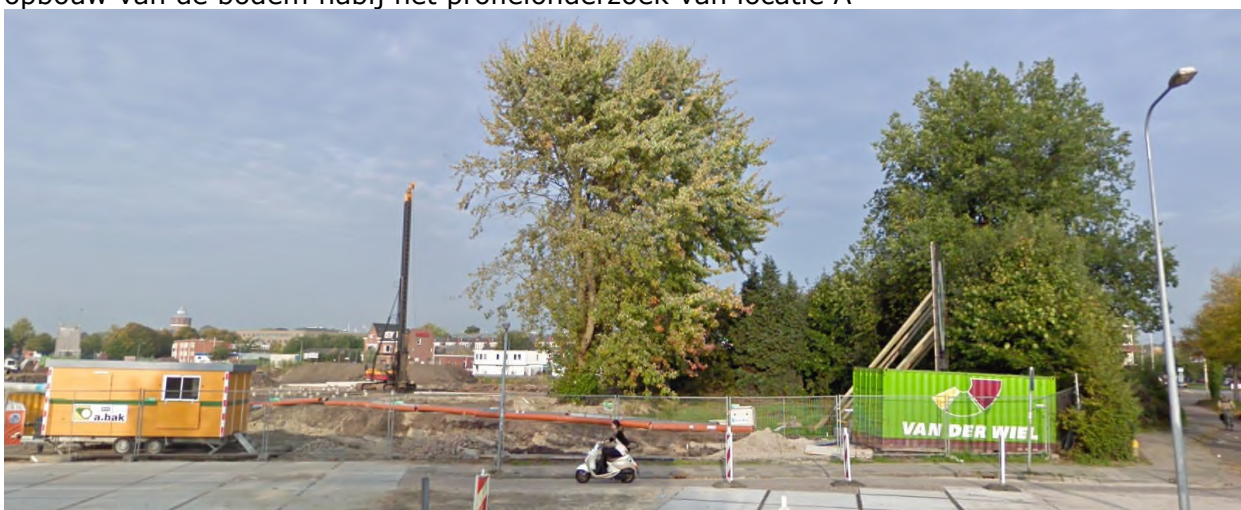
Situatie 2010, weergave van grondwerkzaamheden
