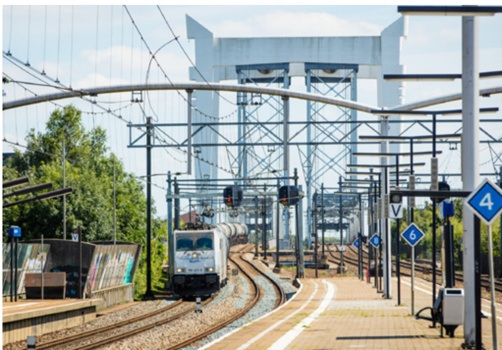
Stefan Verkerk – Vijfhoek, Roozendaal-Zwijndrecht. ERTMS (European Rail Traffic Management Systeem) is de Europese standaard voor spoorbeveiliging.
