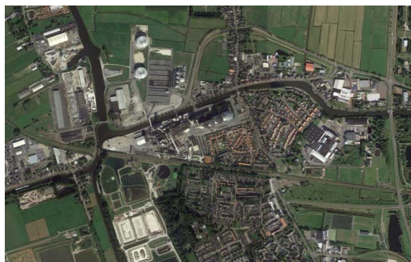
1 Luchtfoto van de situatie
