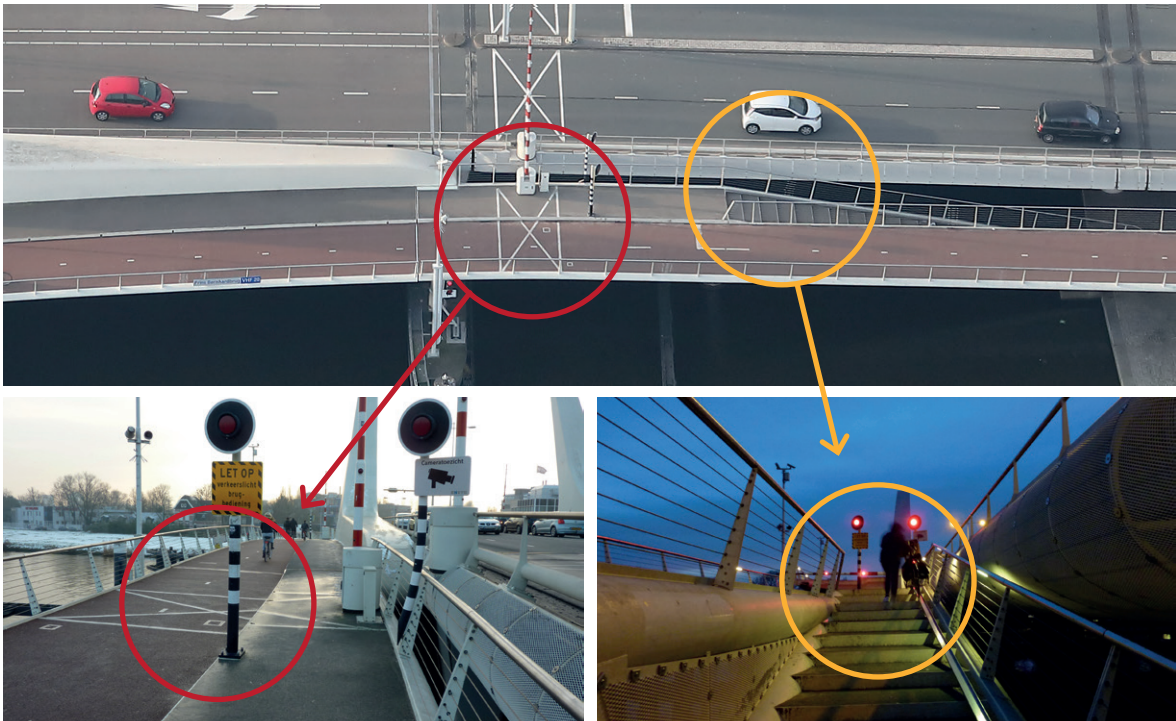
Figuur 10: Voetgangersgedeelte Bernhardbrug. Linksonder: de zuidoostelijke opgang, direct na het bereiken van het einde van de trap bij daglicht. Rechtsonder: de zuidoostelijke opgang in de avond, gezien van onderaan de opgang tijdens een brugopening. (Bron: Onderzoeksraad voor Veiligheid)
