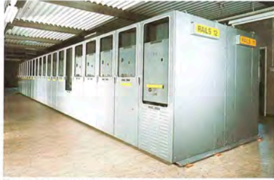
Hoogspannings-Capitôle in rug-aan-rug-opstelling.
