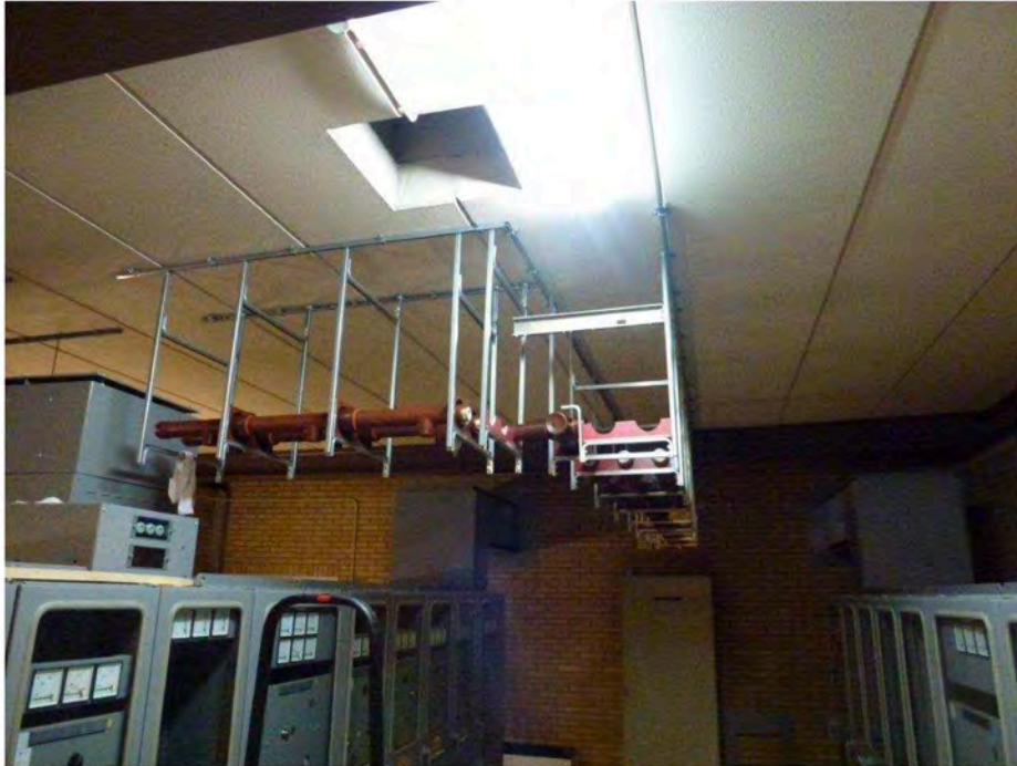
Figuur 2.15 Foto van binnen in het bestaande gebouw.
