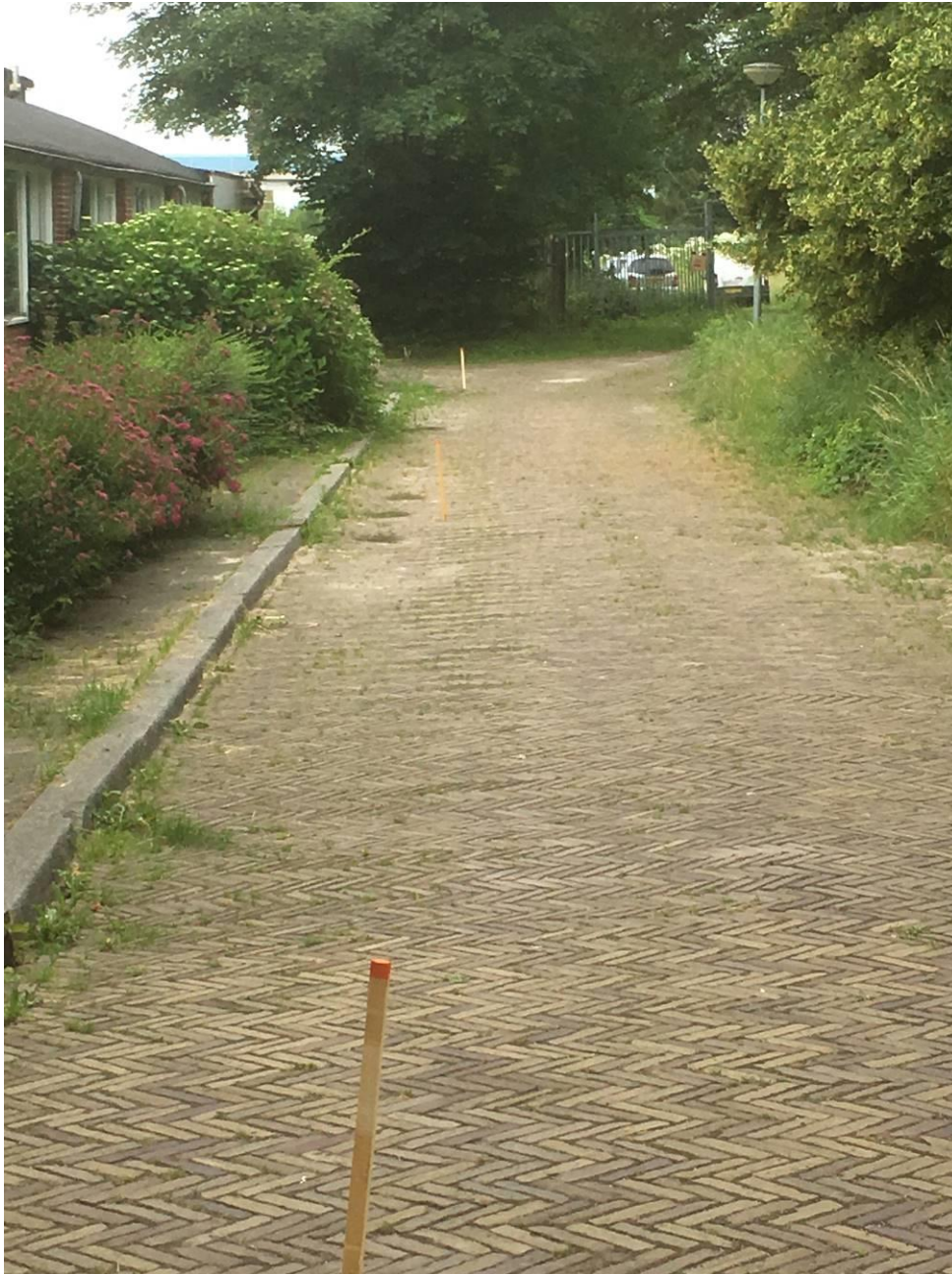
Foto 12 - De piketpalen geven de richting aan waar het riool komt te liggen.
