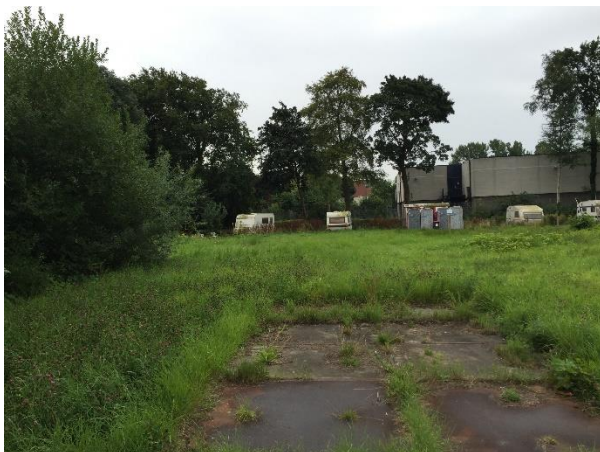
Foto: achterzijde trafo-station (caravan-bewoners)
