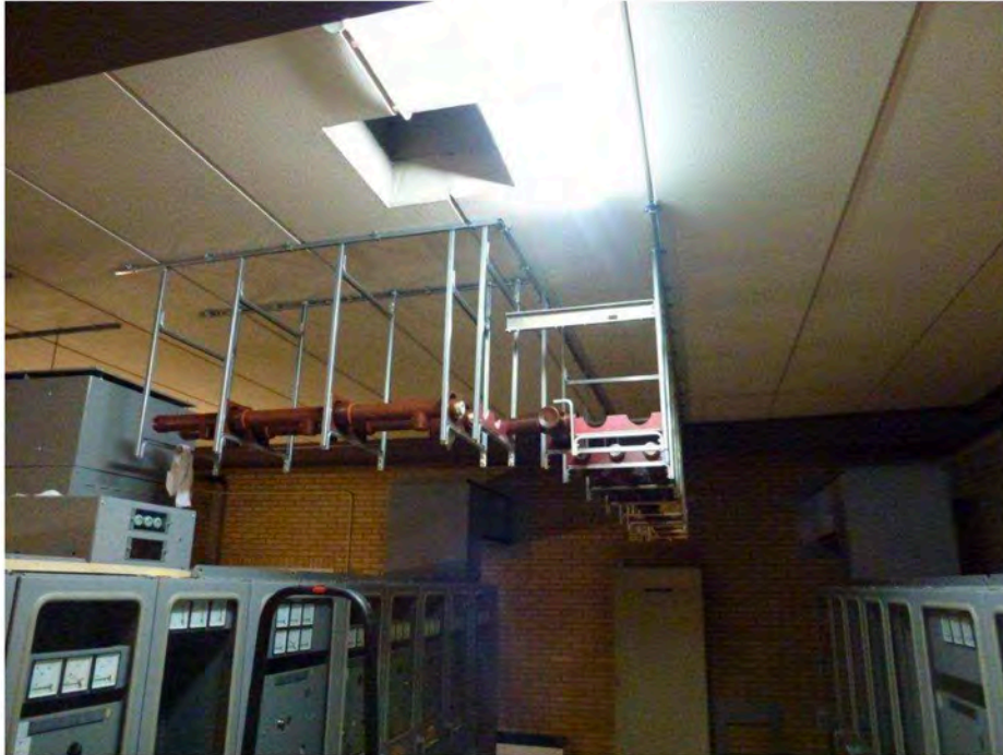
Figuur 2.22 Foto van binnen in het bestaande gebouw
