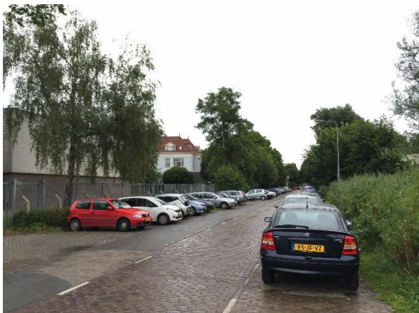
Foto: links trafo-station aan de van Heemskerckstraat
