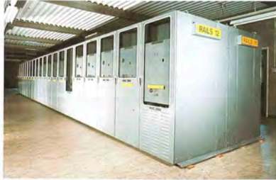
Hoogspannings-Capitôle in rug-aan-rug-opstelling.
