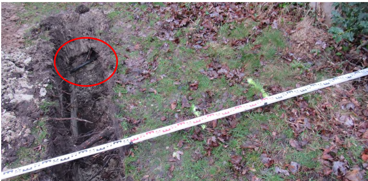
Zichtbaar is de aangetroffen ethyleenslang
