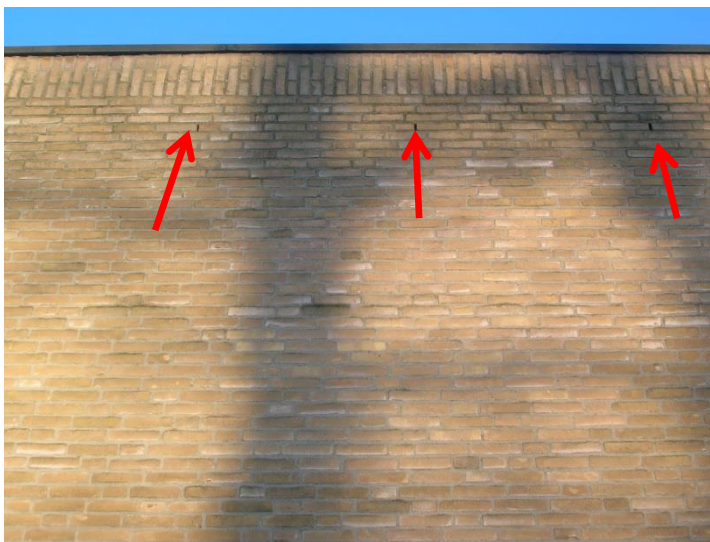
Foto 3 Open stootvoegen zijn voor kleine soorten vleermuizen groot genoeg om toegang te krijgen tot de spouw.
