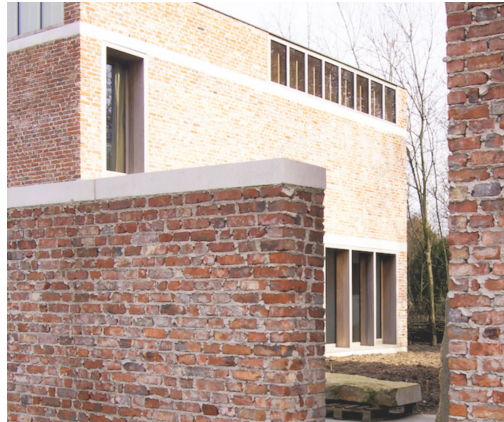
Afbeelding levendige gevel door voegwerk
