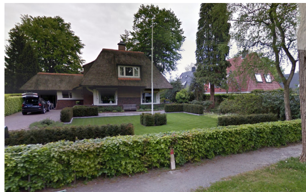
Afbeelding bebouwing Westerse Drift (bron: googlestreetview)
