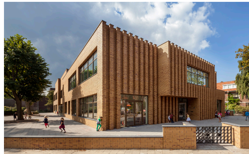
In de architectuur meeontworpen erfafscheiding - Waalsdorp, Den Haag,
