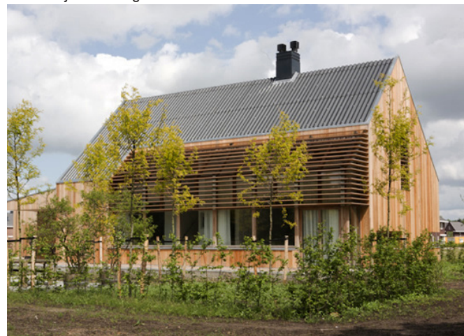
Natuurlijk houten gevel - Paterswolde.
