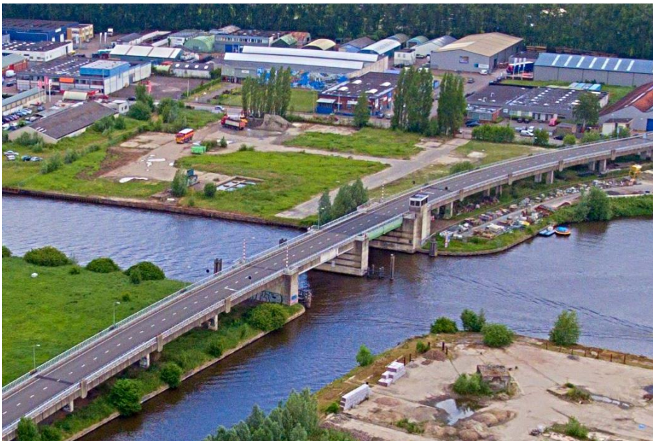
Huidige busbaanbrug over het Van Starckenborghkanaal
