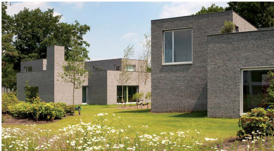
Woning met plat dak - Bosrijk, Eindhoven.
