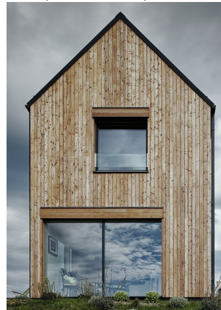
Gevel opgetrokken in hout in natuurlijke kleur - Tocník, Tsjechië
