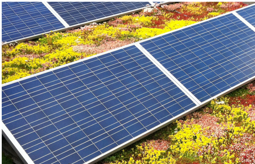
Zonnecollectoren op groen dak.
