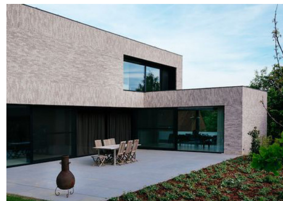
Bakstenen woning met plat dak - Leuven, België
