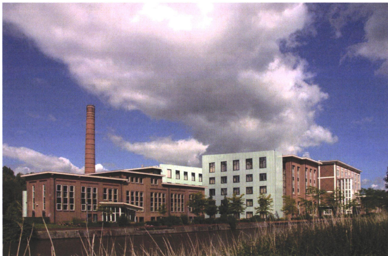
Melkfabriek de Ommelanden, verbouwd tot bedrijfsverzamelgebouw. Foto: gemeente Groningen.
