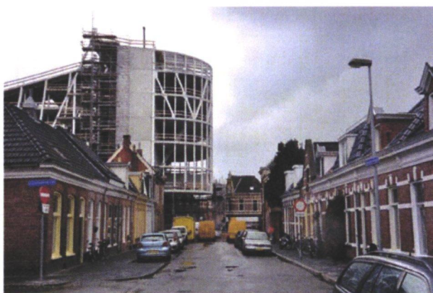
Nieuwbouw op het Damsterdiep in aanbouw. Foto: gemeente Groningen
