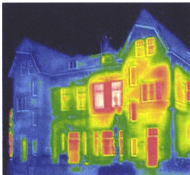
Thermografische foto die het warmteverlies van een pand aangeeft. Copyright afb.: E.J. Nusselder.
