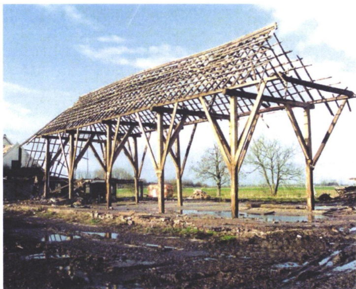
Gebintconstructie uit 1794 van boerderij Zijlvesteweg 6 tijdens de documentatie. Onderdelen zijn herplaatst bij de herbouw. Foto: gemeente Groningen.
