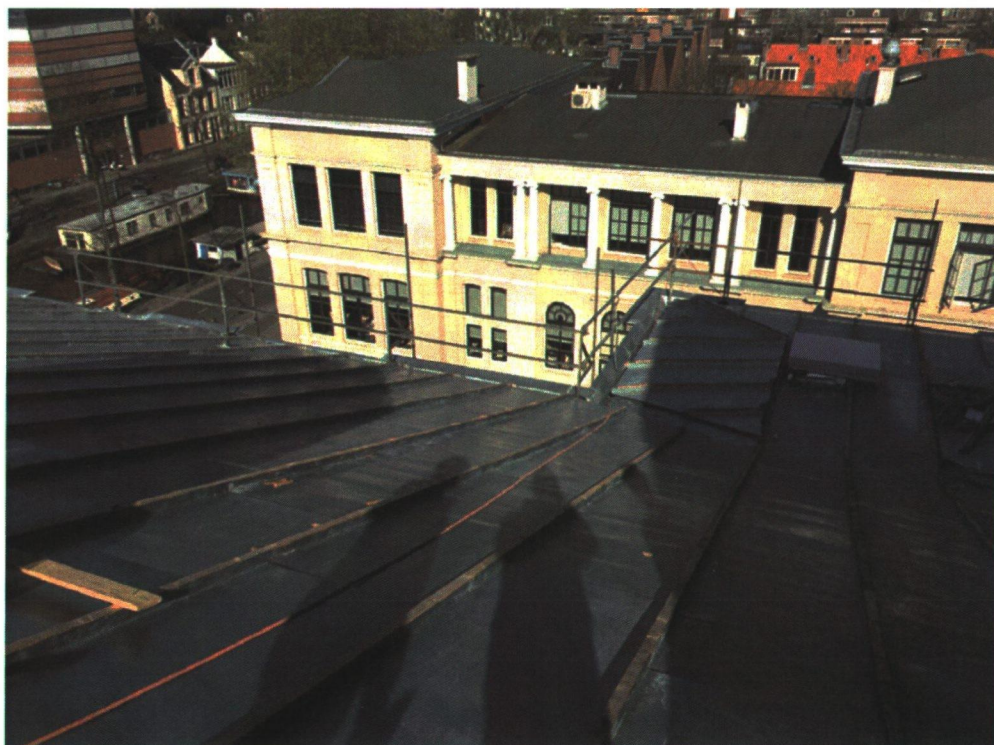
Aanbrengen van het zinken roevendak.
