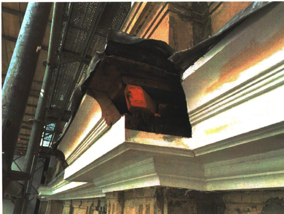
Bij compleet vergane delen werden houten delen vervangen in soortgelijk materiaal en profilering.
