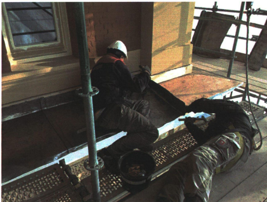
Het lood over de gevellijsten werd geheel vervangen.
