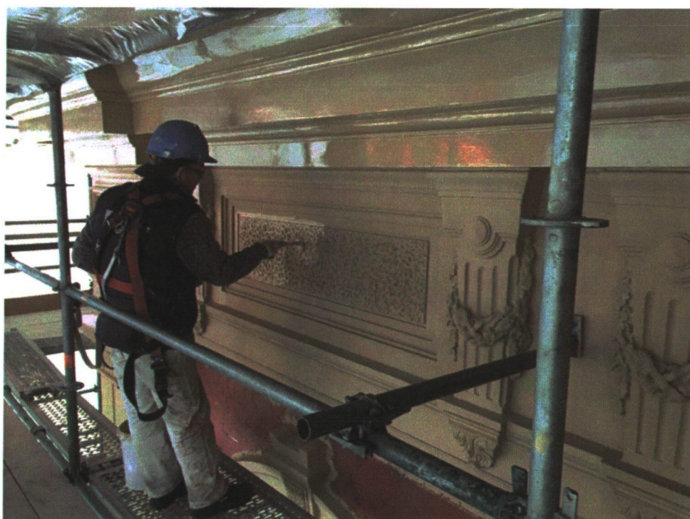
Schilderwerk in uitvoering.
