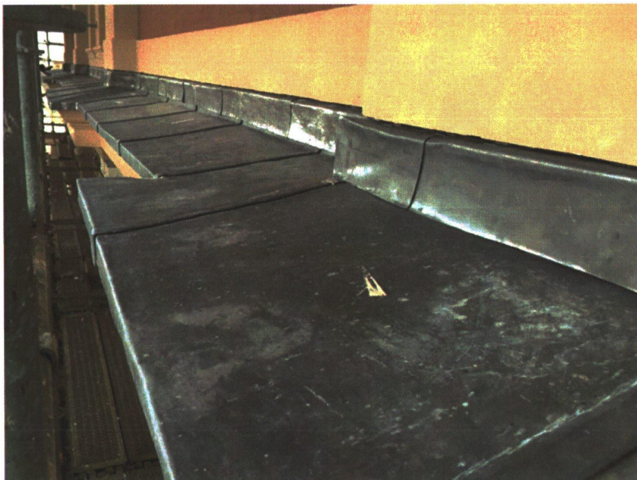
Met veel zetwerk langs de projecterende pilasters.
