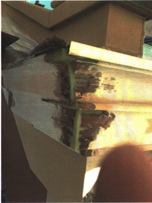
Herstel van verrot hout met behoud van zoveel mogelijk origineel materiaal.
