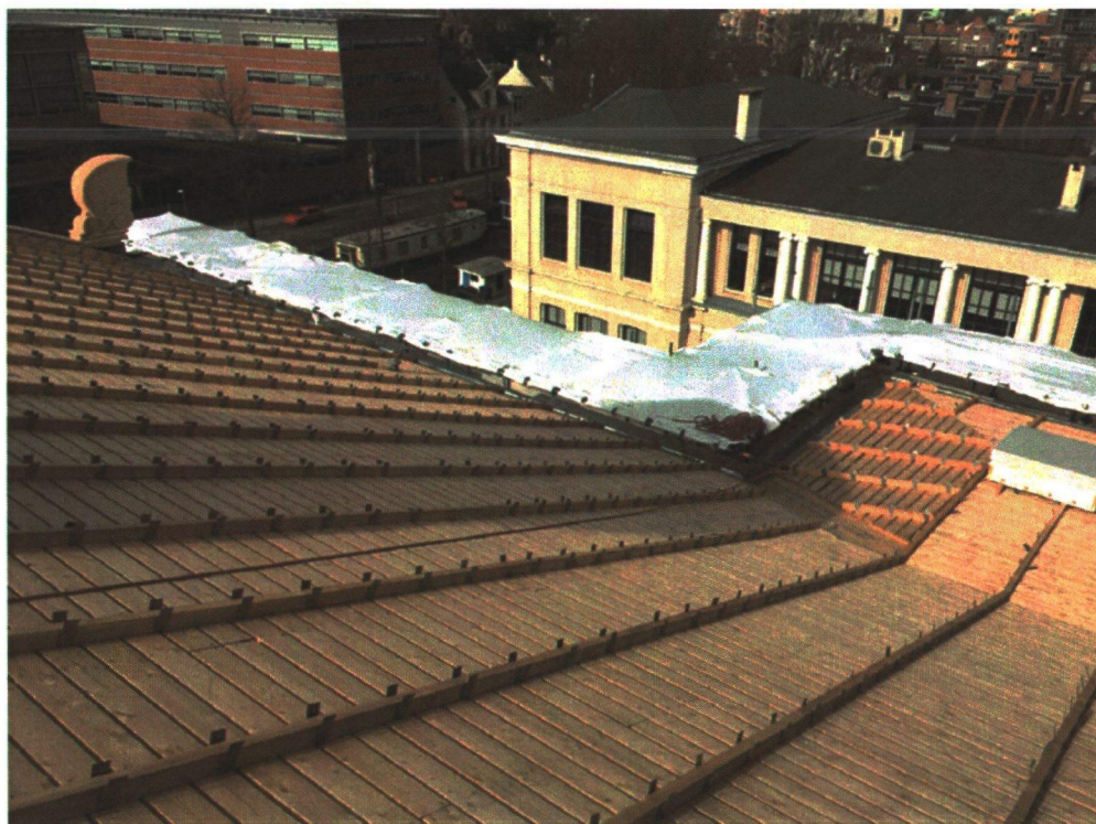
Reconstructie van het zink dak, op het 1883 deel. Aanbrengen onderconstructie.
