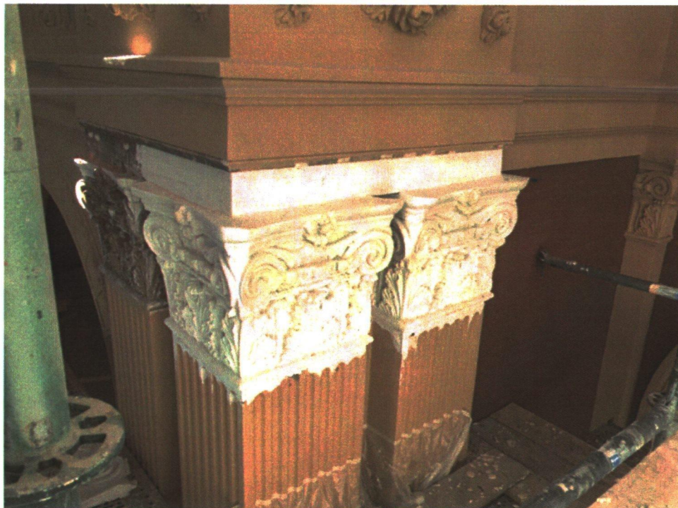
De gereconstrueerde kapitelen vlak voordat het geheel wordt afgeschilderd.
