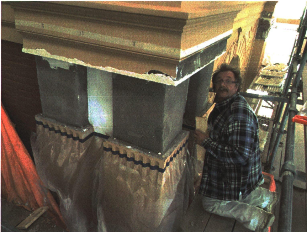
Vorbereidende werkzaamheden voor het plaatsen van de kapitelen.
