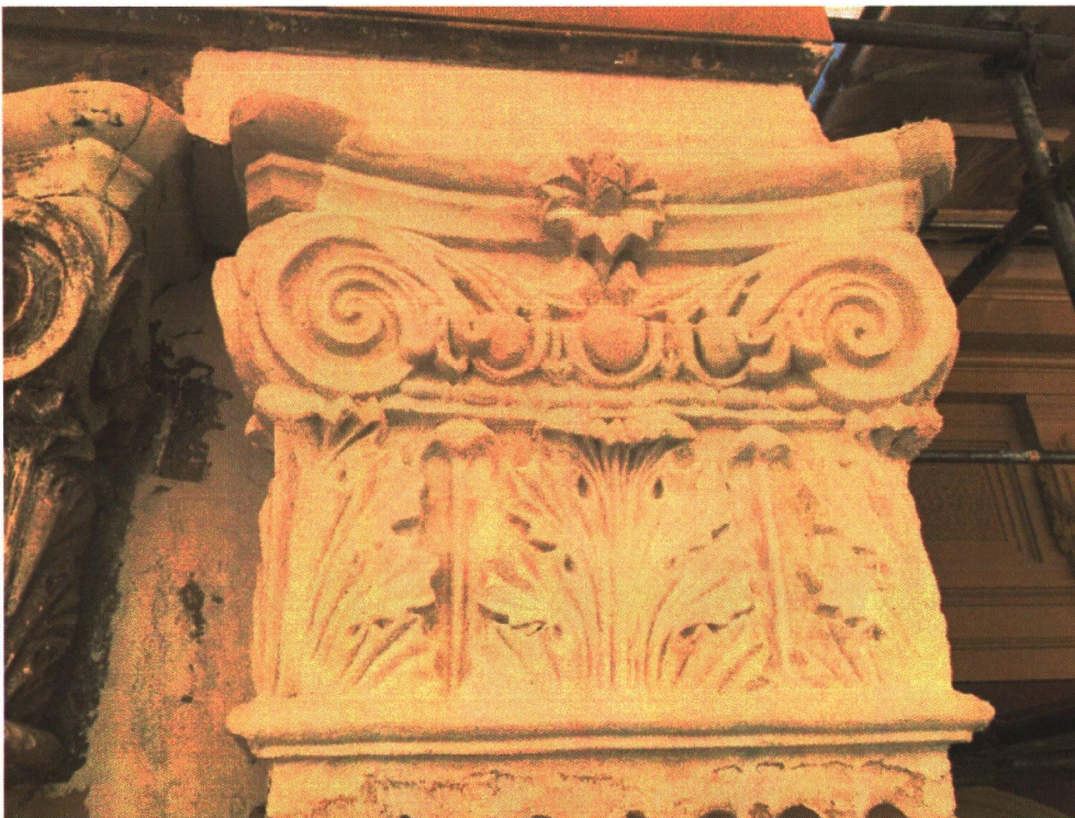
Het resultaat van een opnieuw gegoten kapiteel met behulp van de kunststof mal.
