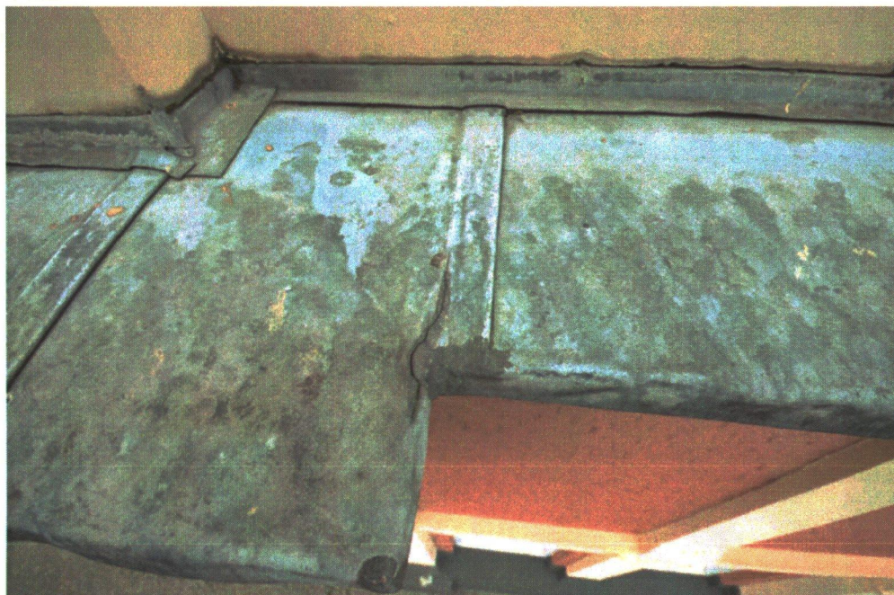
Gescheurd en bijgelapt lood op de gevellijsten.
