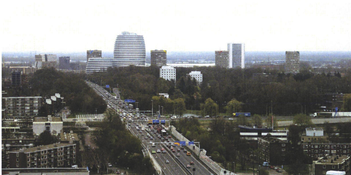
Zuidelijke ringweg Groningen
