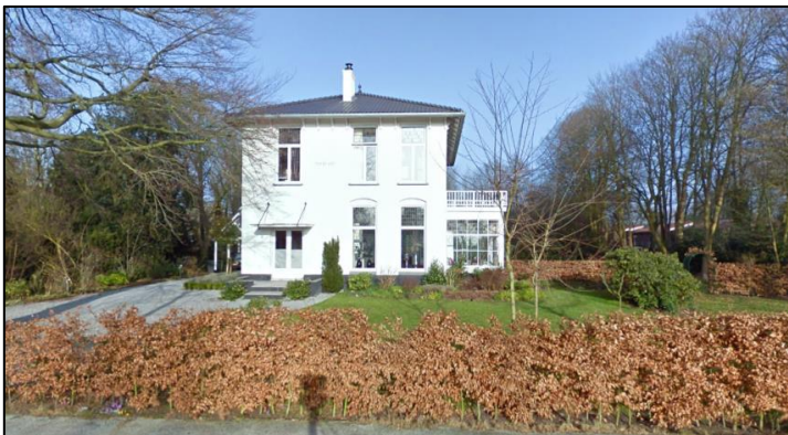
Figuur 5: woning Rijksstraatweg 238 woning er tegenover
