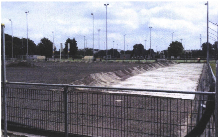
foto ; werk in uitvoering
