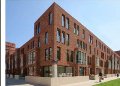
Stedelijke plint langs Sontweg De façade ter hoogte van het Eemskanaal dient kwalitatief ontworpen te worden, naar Groningse kwaliteit.
