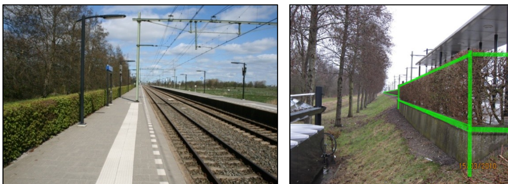
Figuur 13: Geluidsscherm aan de achterkant van de bestaande haag langs het perron
