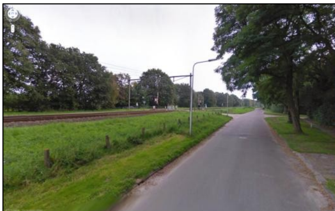
Figuur 9: Spoorwegovergang Oude Schoolweg in Glimmen
