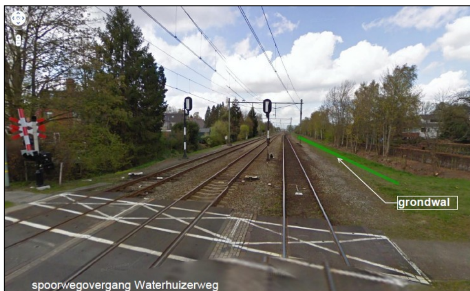
Figuur 18: Grondwal langs de oostkant van het spoor
