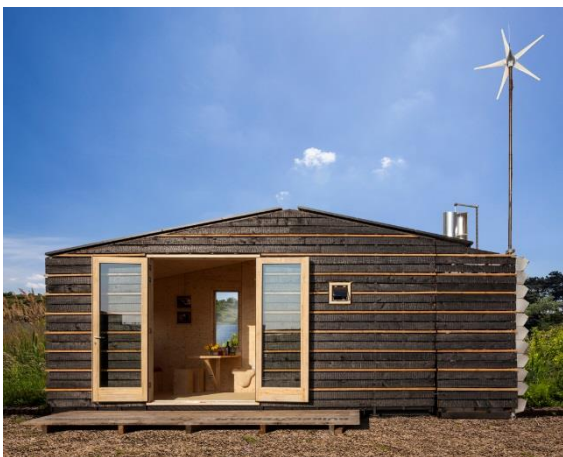
Fig. 2 De Tiny TIM is een Tiny House gebouwd door een architectenbureau en dus niet door de bewoners zelf. Bovendien heeft het geen wielen, maar is het wel verplaatsbaar. Daarnaast is het huisje volledig zelfvoorzienend, inclusief eigen waterzuivering. (Tiny TIM House, 2017).
