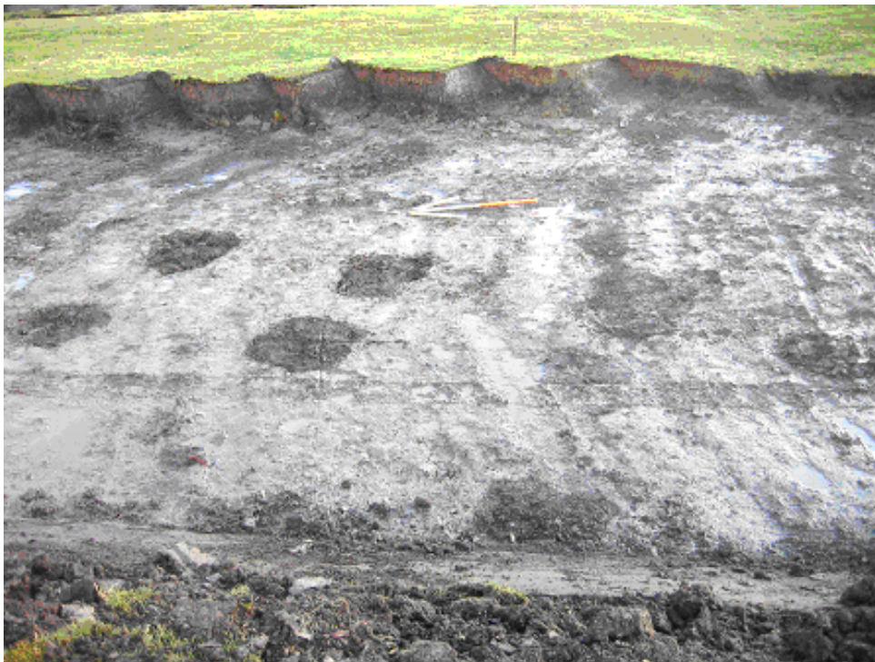
Deel van het ontgraven westelijke bassin van het helofytenfilter voor aanvang van de archeologische werkzaamheden. Duidelijk te zien zijn de paalkuilen die de directe aanleiding voor het onderzoek gaven.
