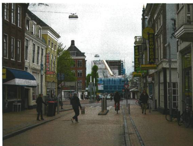
Afbeelding: kantoor Nijestee in aanbouw gezien vanuit Steentilstraat
