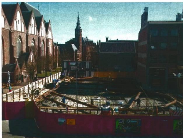
Afbeelding: nieuwbouw Vindicat
