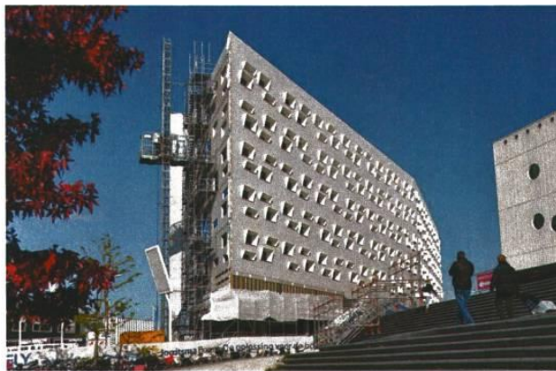
Afbeelding: Alfacollege in aanbouw
