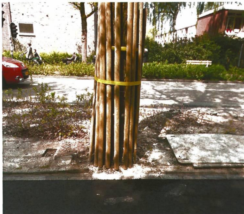
asfalteringswerkzaamheden bij boom nummer 8-167
