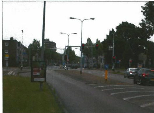
bestaande middengeleider Paterswoldseweg die omgevormd wordt tot voorsorteerstrook voor links af.
