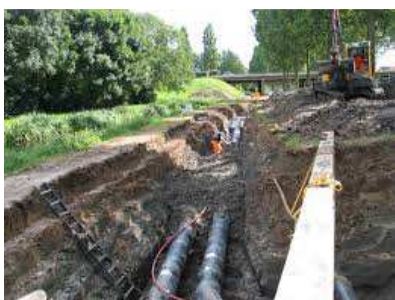
Figuur 5 het leggen van distributieleidingen
