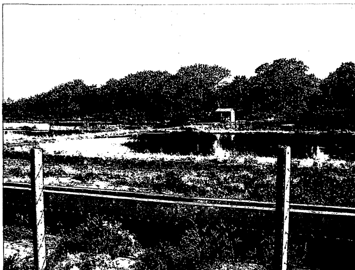
De biologische rioolzuiveringsinstallatie met 5 bassins wordt binnenkort in gebruik genomen.
