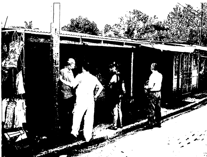
Woningverbetering in uitvoering
