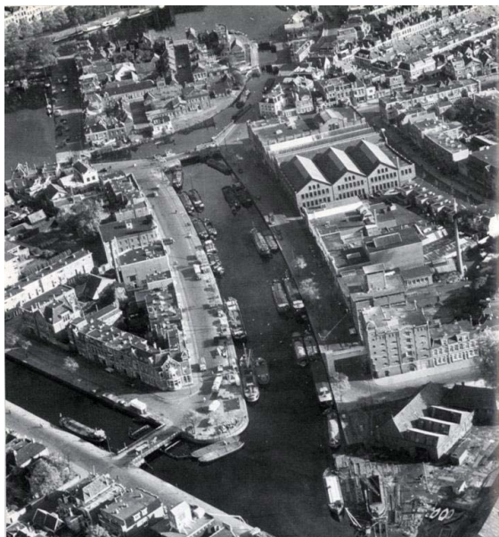
Luchtfoto. Hoendiep, Eendrachtskanaal gezien naar het oosten, circa 1950
