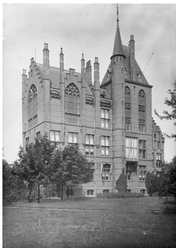
Melkweg 1, vlak na de bouw
