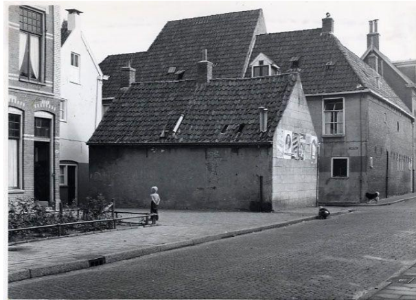
Agricolastraat vóór de sanering
