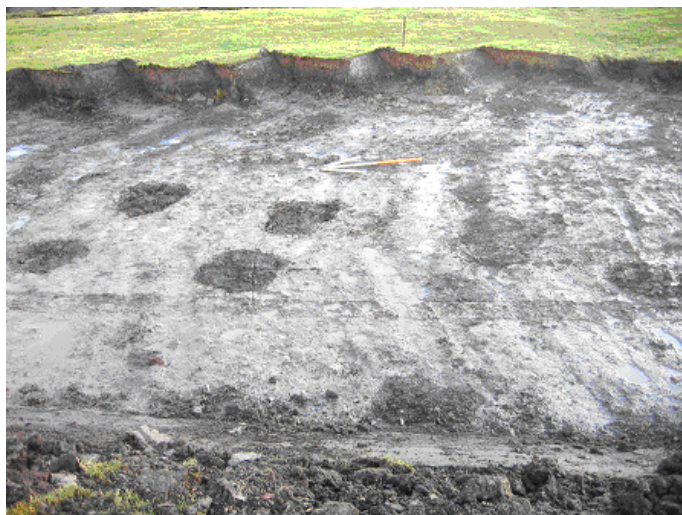
Deel van het ontgraven westelijke bassin van het helofytenfilter voor aanvang van de archeologische werkzaamheden. Duidelijk te zien zijn de paalkuilen die de directe aanleiding voor het onderzoek gaven. Foto: ARC
