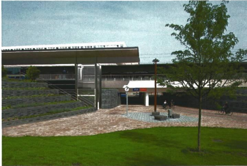
Station met nieuwe perronkap en lift – Helperzoomzijde
