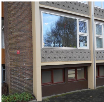
Spouwmuren vullen, borstwering isoleren
