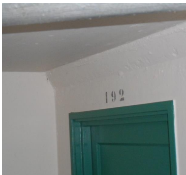
Plafonds in bergingen isoleren
