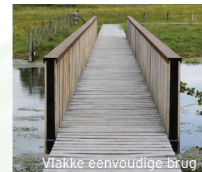
Vlakke eenvoudige brug
