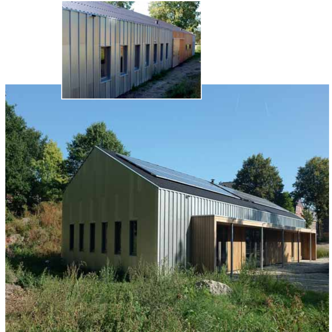
38) Buurtcentrum, Bessemoerpark | Kwint architecten
