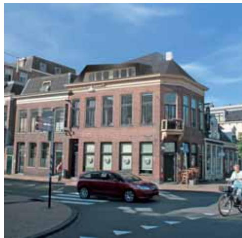
34) Dakopbouw, Gedempte Zuiderdiep pvanb architecten
