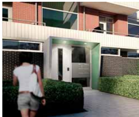
32) Renovatie en verbouw portiek-etagewoningen, Reviusstraat, Camphuysenstraat | pdb design
