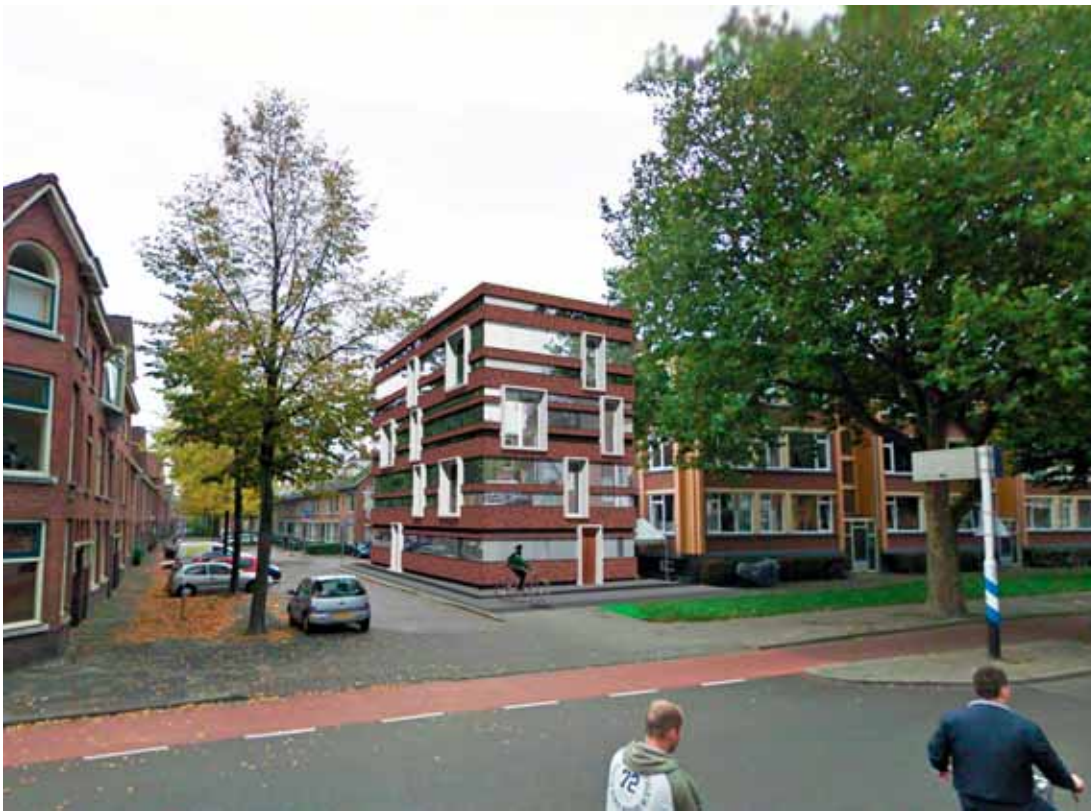
40) Verbouw bijgebouw portiek-etagewoningen, Bedumerstraat | Urban Climate Architects
