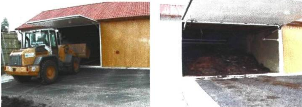
Afbeelding 4: Een reactorruimte van een droogvergister wordt gevuld met de shovel, rechts met geopende gasdichte deur. Een unit bestaat uit 10-12 van deze ruimtes.
