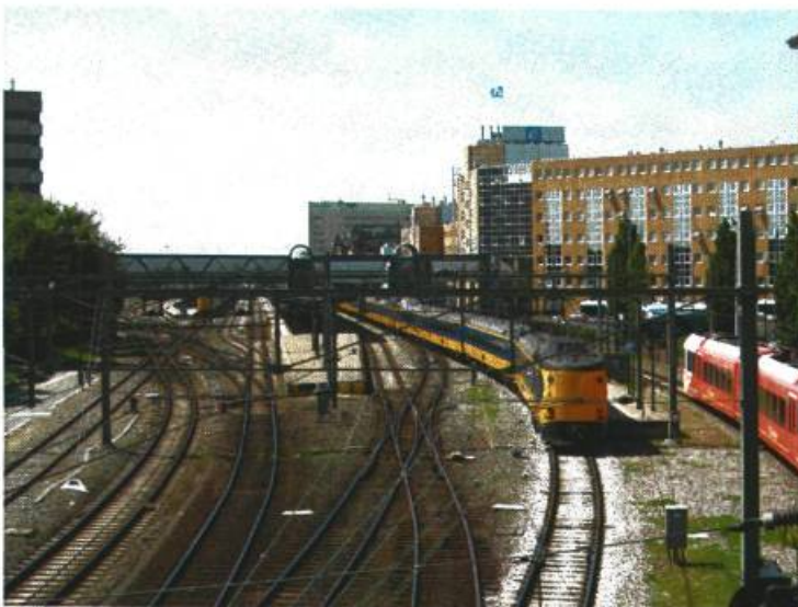
Afbeelding: Stationsgebied vanaf Herewegviaduct
