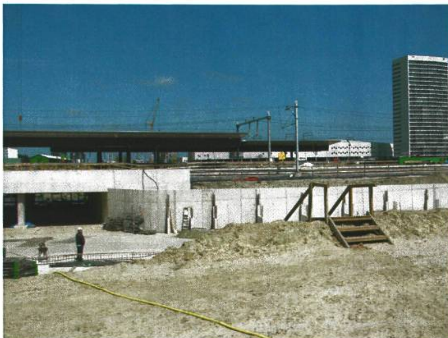
Afbeelding: Station Europapark in aanbouw, vanaf de Helperzoom
