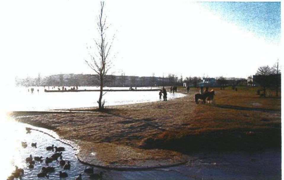
afb.: steigers, dijkprofiel
