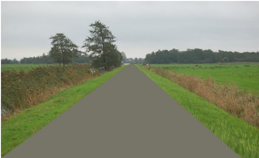
Verbreed fietspad Leeksterhoofddiep (3,5 meter)
