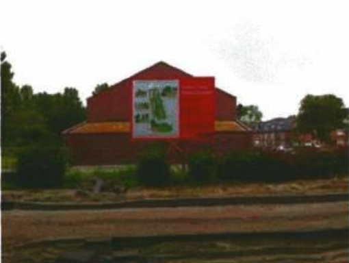
Bessemoeerpark in uitvoering
