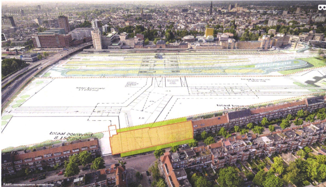
Afbeelding 5.2.10 Maar het huidige hoekblok Spaarnestraat vormt een belemmering en dient gesloopt te worden.
