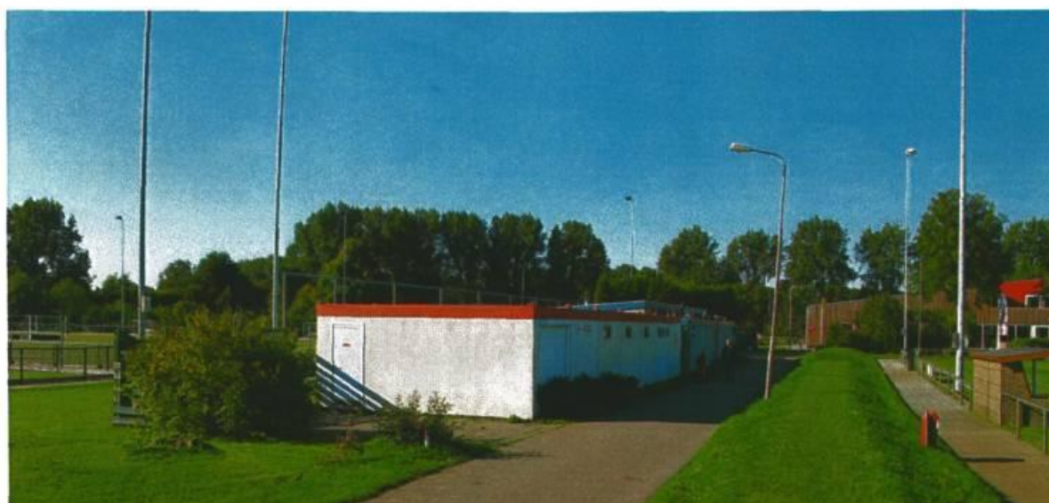
Weergave van de te slopen kleedkamers
