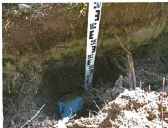
Zichtbaar grondwater op ca 70cm diepte
