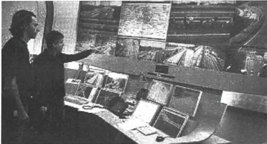
Figuur 3: Verkeerscentrale Noord Oost Nederland in Wolfheze
