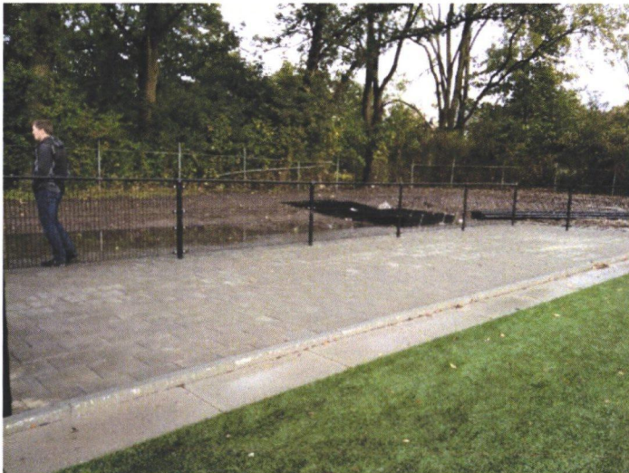
Foto Velocitas veld 2, verhoogd opsluitband om SBR rubber infill op het veld te houden.
