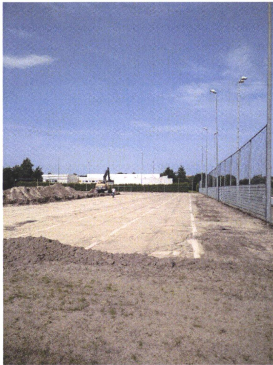
Foto; Ontgravingswerk veld 4 Sportpark de verbetering HFC'51
