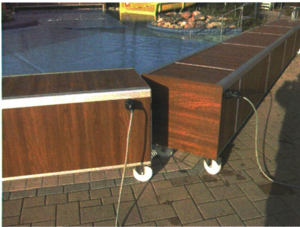
Verrijdbare bank met folie afdekking
