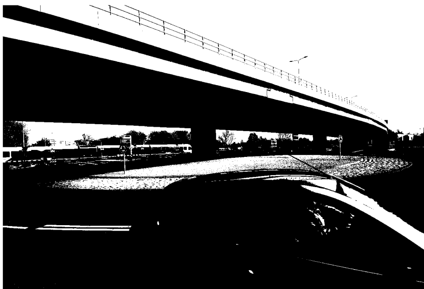
Ongelijkvloerse ring: Oostelijke Ringweg
