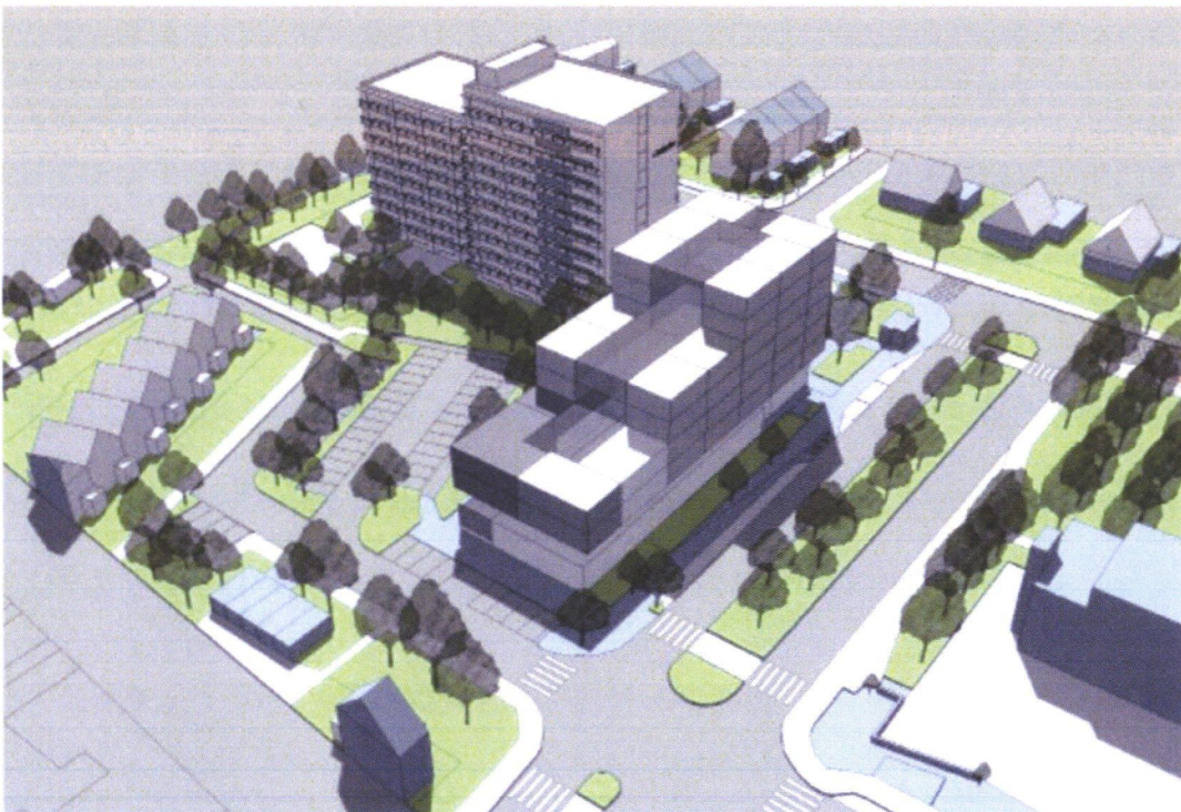
Getrapte nieuwbouw boven supermarkt hoek Bordewijklaan/Vestdijklaan met daarachter de parkeerplaats aan De Mérodelaan en de hoge Zuiderflat
