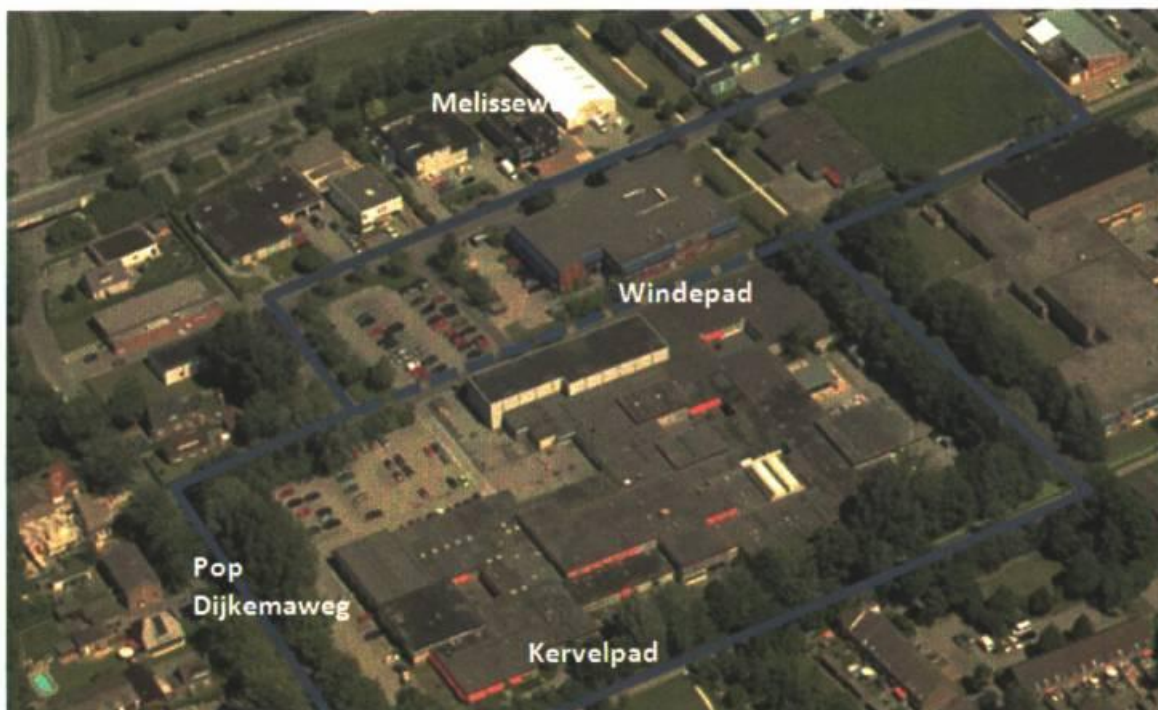
Luchtfoto van het plangebied (bron: Bing maps)
