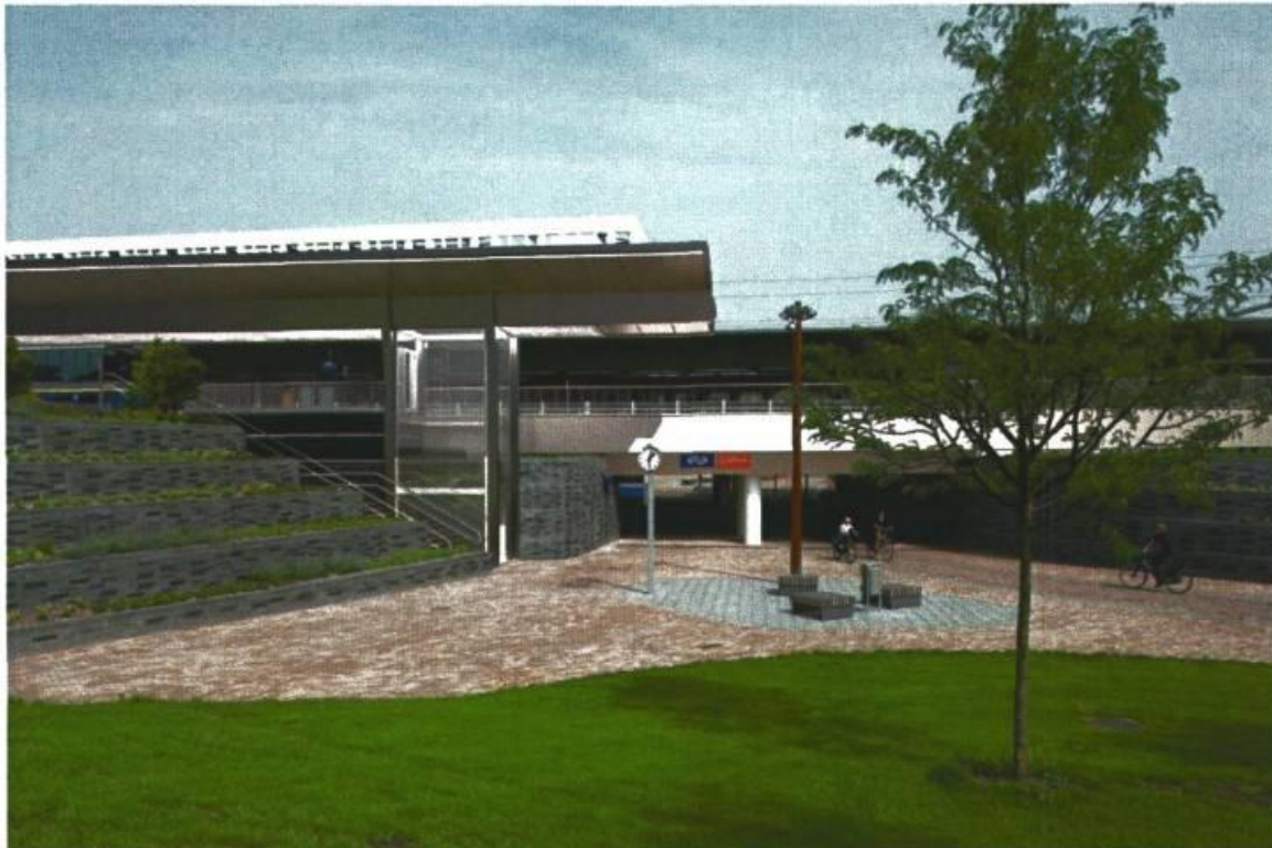
Station met nieuwe perronkap en lift – Helperzoomzijde
