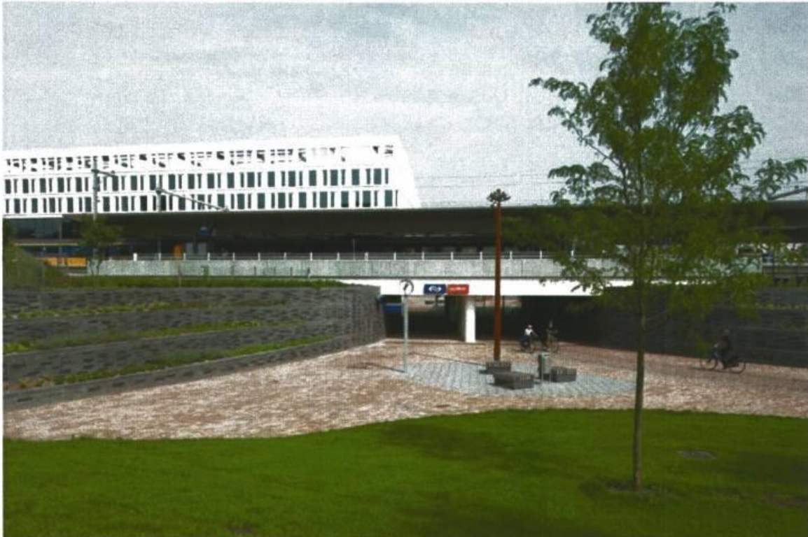
Bestaande situatie – Helperzoomzijde
