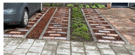
Figuur 1: weergave hoe een bui kan worden opgevangen in verschillende compartimenten
