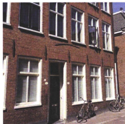
Een van de verbouwde panden: Muurstraat 11 - foto R. Veenstra
