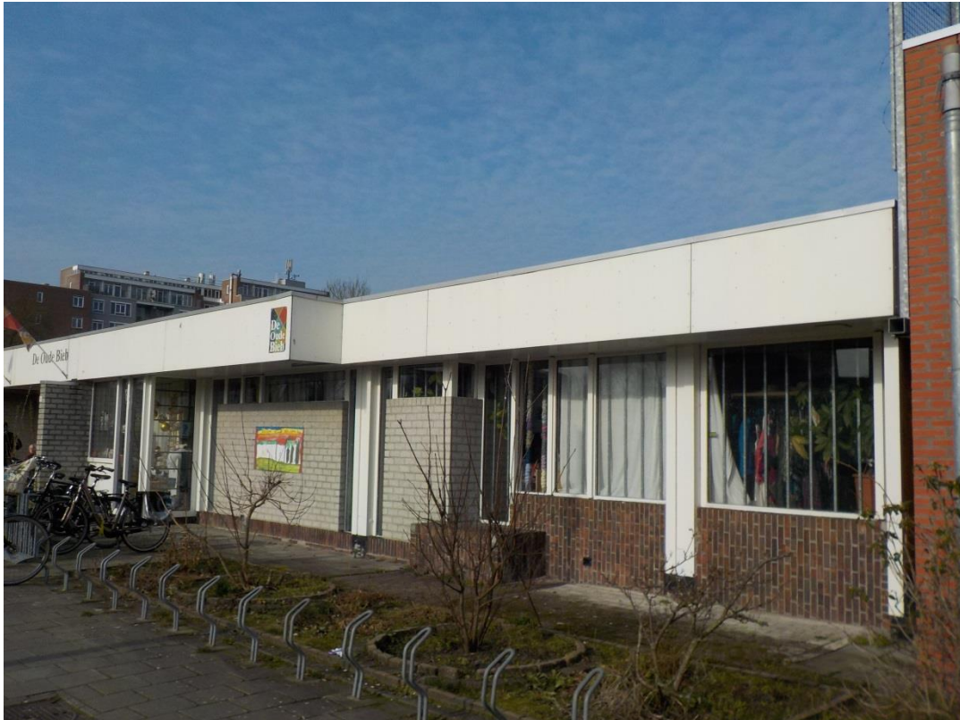
Foto 1 Impressie van het onderzochte gebouw.
